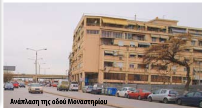
Κατασκευή της υπόγειας οδού Μοναστηρίου - Έλλης Αλεξίου - Αγ. Παρασκευής και αντιστρόφως
